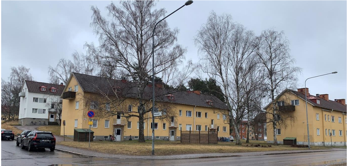
Kvarteret sett från korsningen Stensättersgatan-Bievägen.
