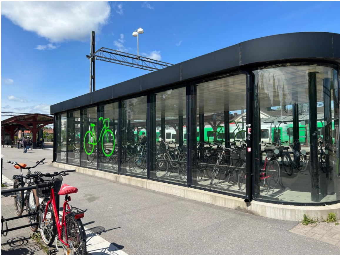
Figur 15: Cykelgarage på platsen
