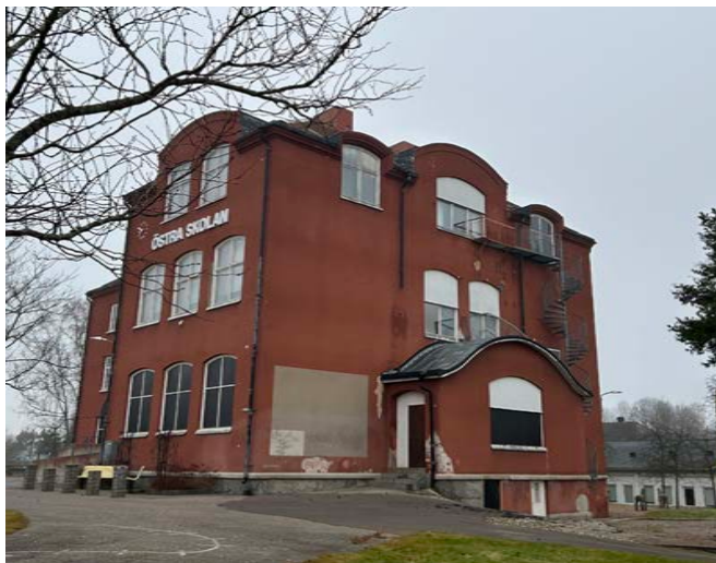
Trots sentida förvanskade åtgärder har Östra skolan en i stort bevarad fasad som är tydlig i sitt jugendformspråk.
