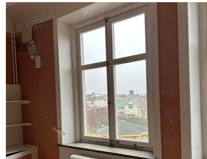
Flertalet äldre fönster finns bevarade i byggnaden med spanjoletter och andra äldre värdebärande beslag. Utöver detta finns även äldre fast inredning bevarad som dörr- och fönsterfoder, dörrar, skåp osv.
